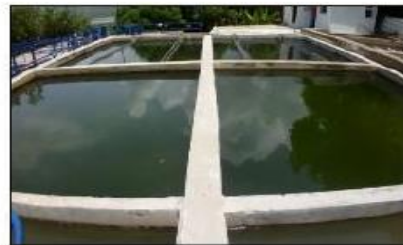
Foto 54. Módulos de Sedimentación PTAF
