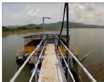
Foto 49. Componente de Captación – Barcaza Flotante
